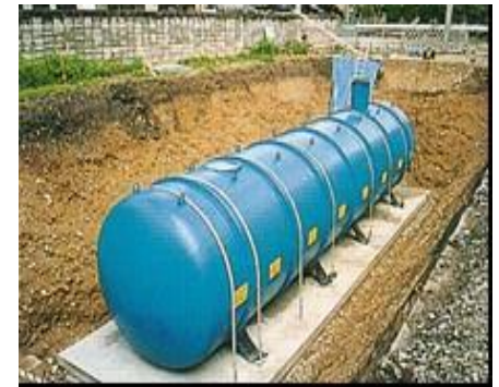
【耐震性貯水槽】
